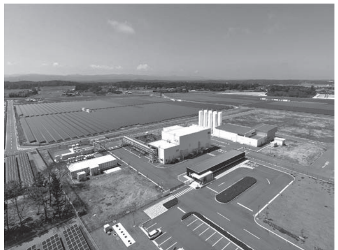
FH2R の全景 (日建設計コンストラクション・マネジメント 提供)
