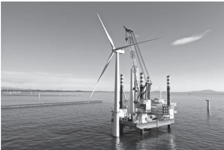
能代港での風車据付の様子 (出典：秋田洋上風力発電株式会社)
