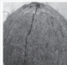
割れている (Cracked)
