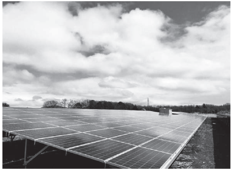
エネグローバルが開発した太陽光発電所(同社より写真提供)
